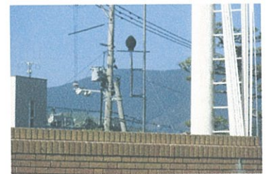
騒音測定器 佐伯支所 防災センター屋上
